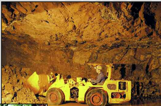
Stollenauffahrung der Forschergruppe Steiber im Sprengvortrieb mit LHD- Technik.
